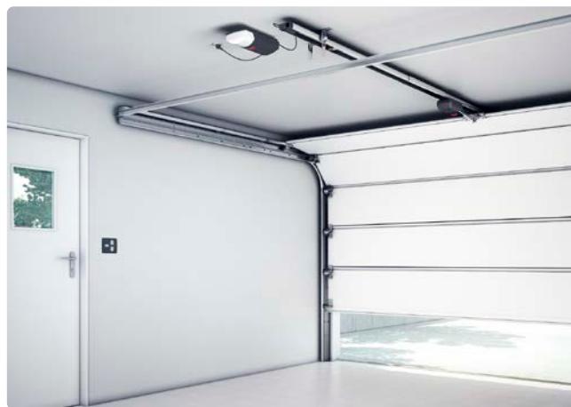
Installazione su soffitto
